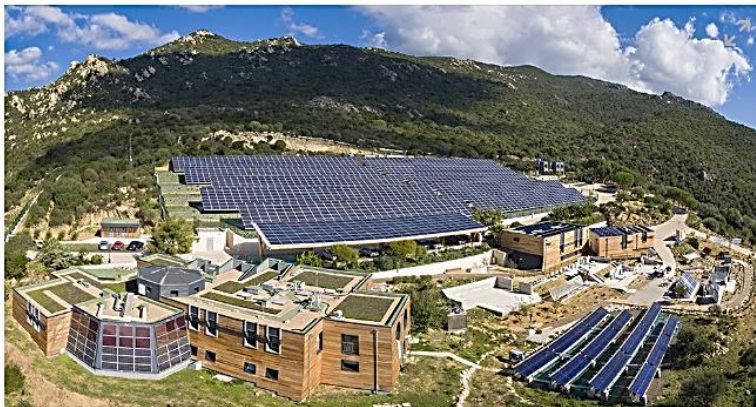
L'unité pilote de STEPSol est installée sur le centre de recherche de l'université de Corse, à Ajaccio. L'énergie solaire y est en partie stockée pour être restituée la nuit grâce à un mécanisme hydraulique.
